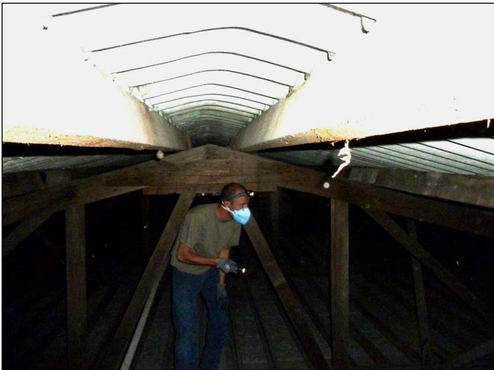
Abb. 4: Garagenkomplex mit Asbestdach und Dachbinder (Foto: 16.07.2014).
