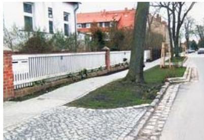
wasser flächenhaft in die begrünten Seitenbereiche abgeleitet und dort versickert wird. Dazu wurden die alten Straßenborde wieder neu, aber mit Lücken versetzt. Zur besseren Versickerung wurden dahinter Sickerstränge mit Kiesfüllung angeordnet.
