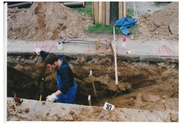
Hier wurden Leitungen verlegt und die Fahrbahn erneuert, wobei die Aufgrabungen keinen nennenswerten Wurzelbestand in der Asphaltfahrbahn zu Tage brachten.
