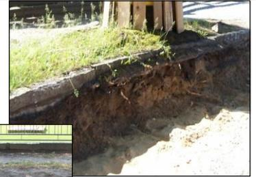
keine Wurzeln im Straßenkörper, da Versiegelung Luft- und Wasserdurchlass verhinderte
