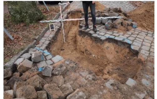
Abb. 4: Alleebaum Nr. 34 mit der Auskofferrung durch Handschachtung, ohne Befund von Wurzeln.
