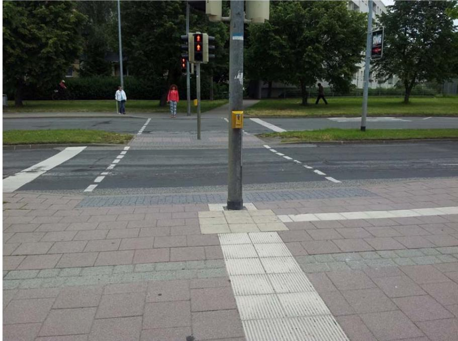
**Bild 15:** Hamburger Allee – Fußgängerübergang mit Lichtsignalanlage und Blindenleitsystem
