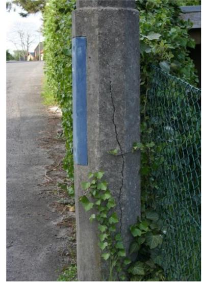
Bilder 5 bis 7: beispielhaft ein Lichtmast Breite Straße Ecke Knöchernhorst mit neuem Leuchtmittel, aber mehreren Rissen im gesamten Lichtmast
