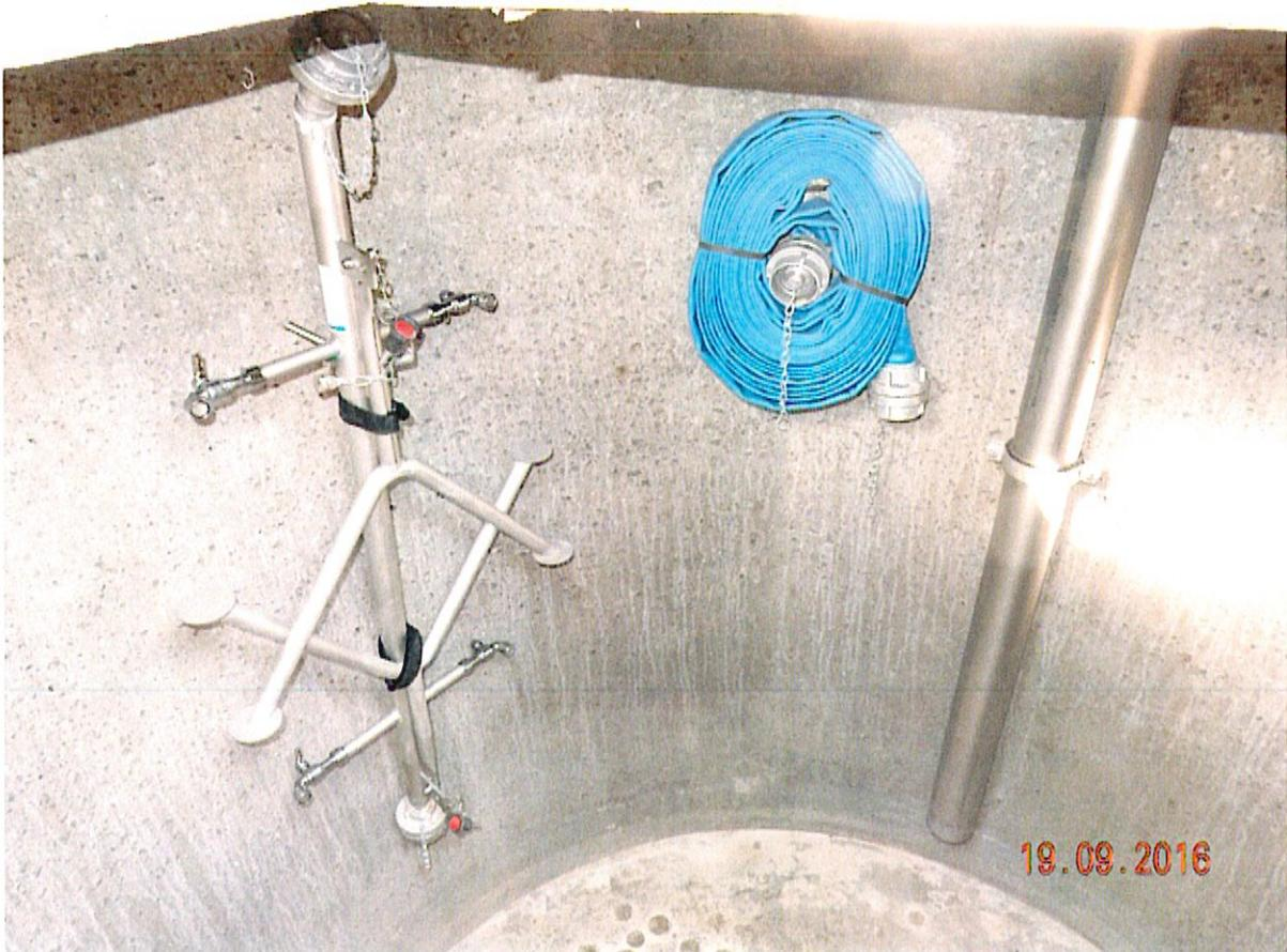
Notwasserbrunnen von Innen mit Einstiegsleiter, Lüftungsrohr, Gruppenzapfstellen, TW-Schlauch, Brunneninformationstafel und Knickschutz
