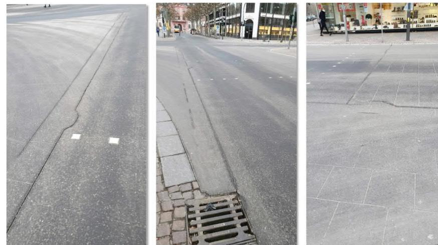
Ludwigstraße, Prägeasphalt, großformatig, schwarz mit deutlichen Abnutzungsspuren in der Fahrspur, Rißbildungen im Bereich der „Fugen“
