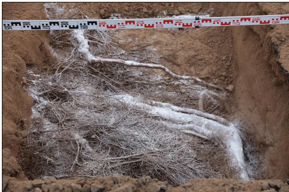
**Abb. 2: Alleebaum mit freigelegtem Wurzelwerk, durch Handschachtung und Freispülung mittels Druckluft.**
